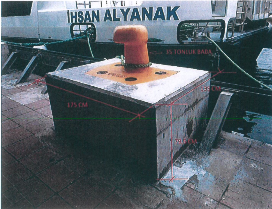
Resim 3.1. Yapılacak olan 35 tonluk babanın Bostanlı iskelesinde bulunan bir örneği resmi ve ölçüleri
